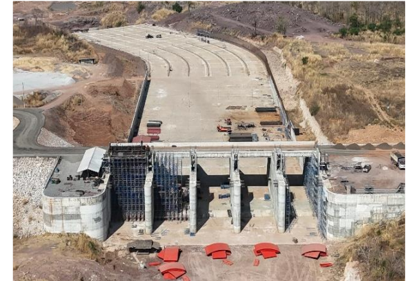
ทางระบายน้ำล้น (Spillway)
