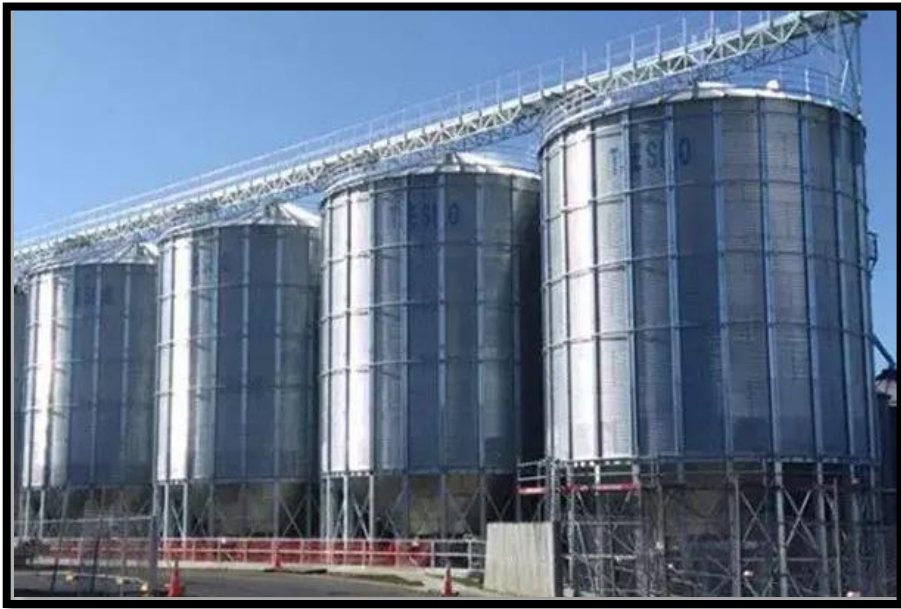
ถังไซโล (Silo Storage) ถังระบบปิด เพื่อควบคุมอุณหภูมิและความชื้น
